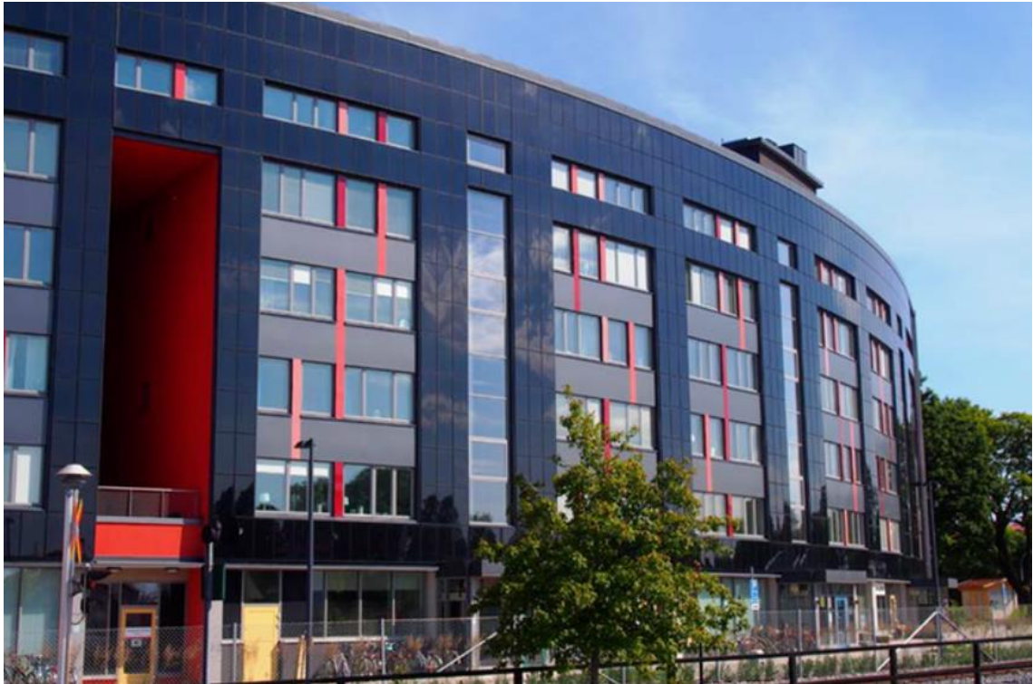
Рис. 1.8. Фасадні BIPV сонячні електростанції
