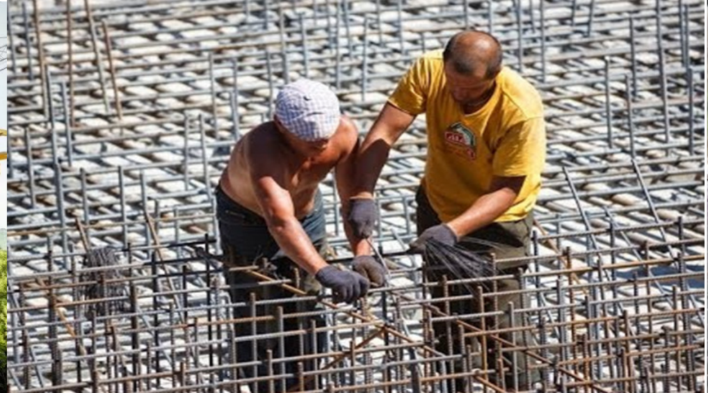
Армування перекриття
