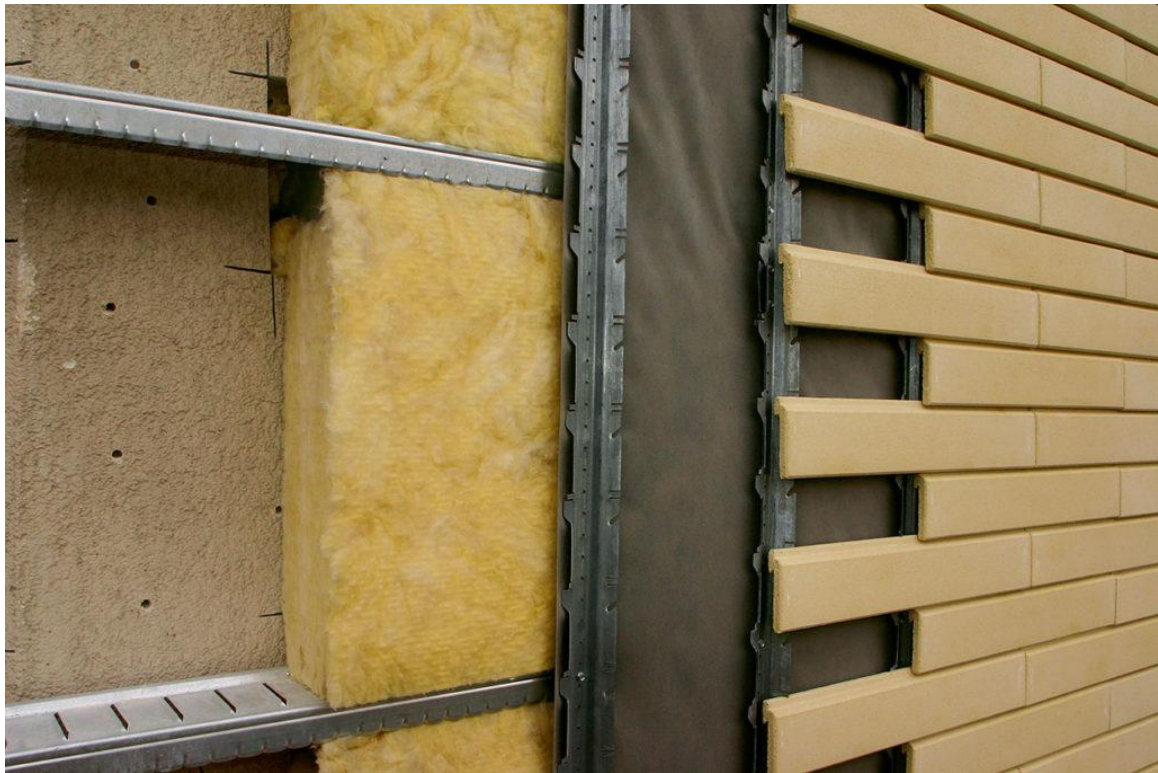
Рис.14 Приклад вентильованого фасаду
