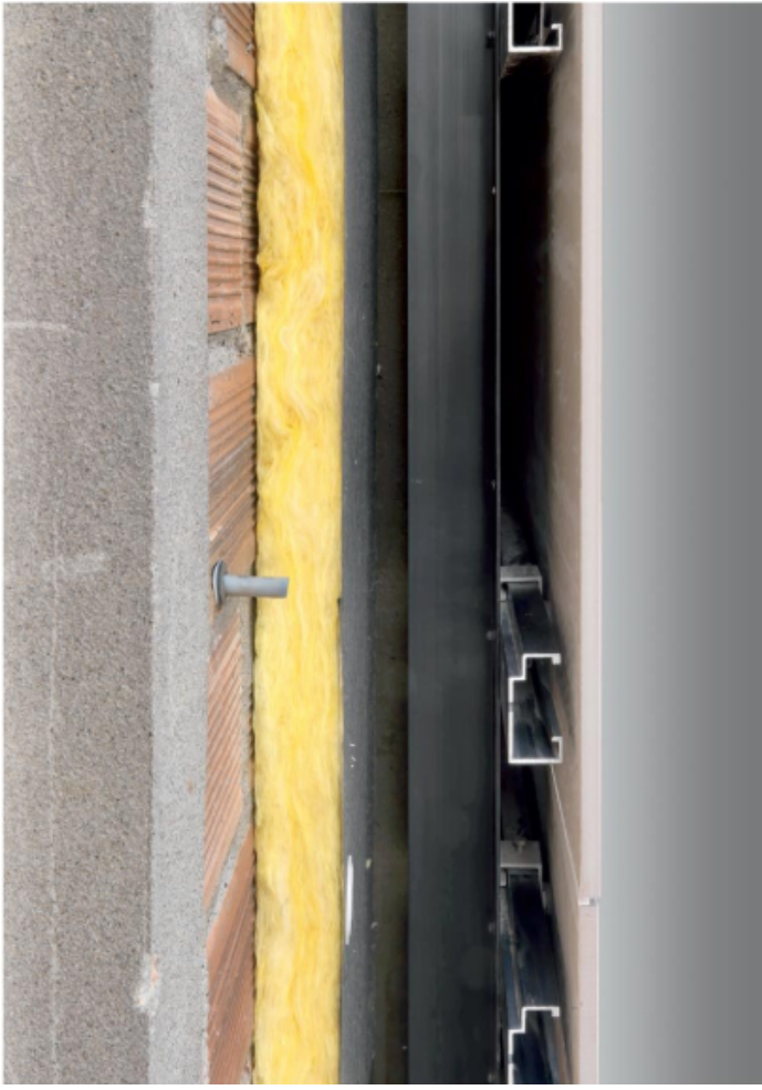
Рис.12 Конструкцію вентильованого фасаду
