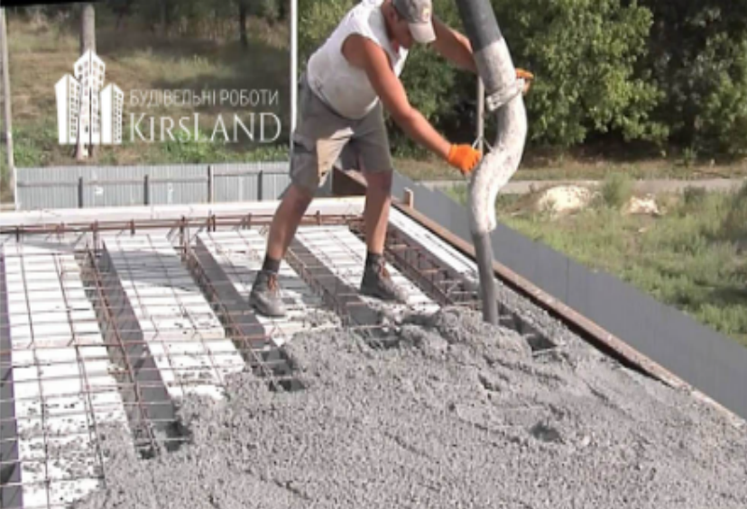
Бетонування перекриття
