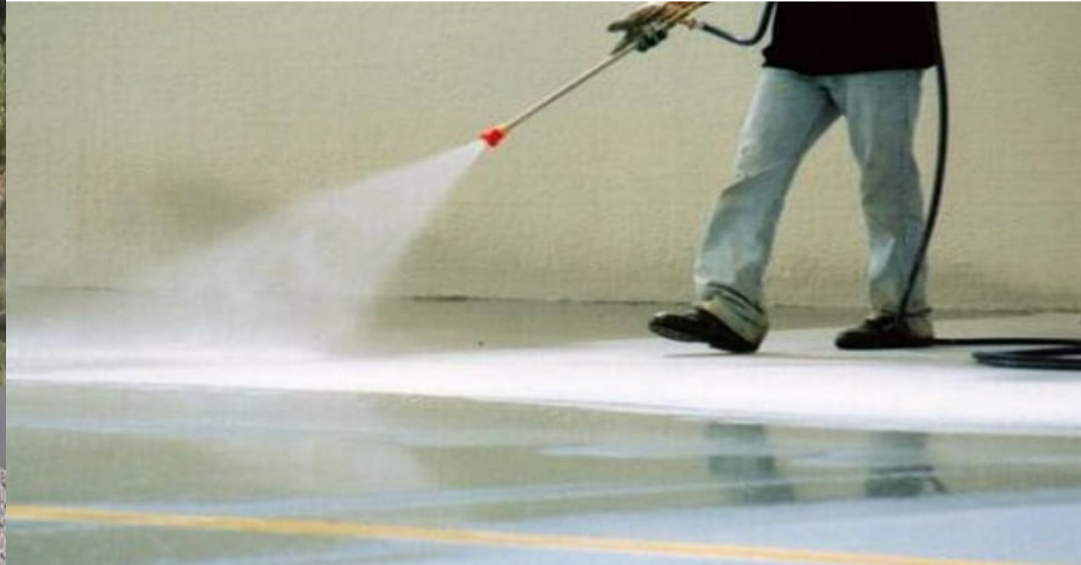
Догляд за бетоном
