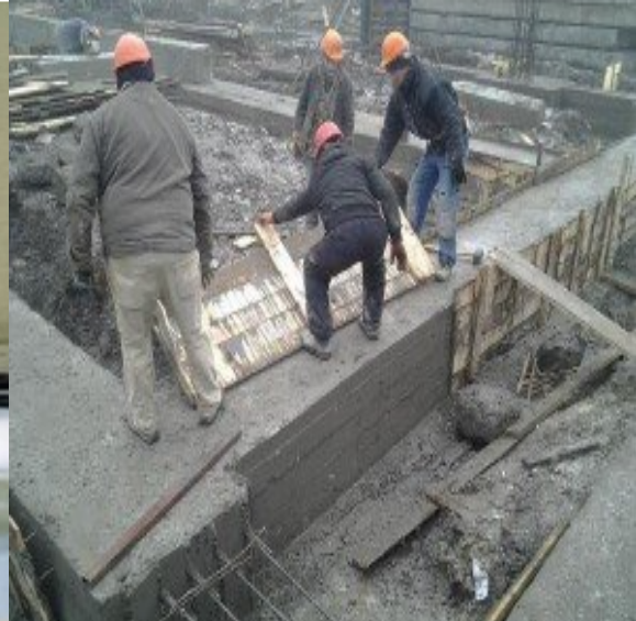
Демонтаж опалубки
