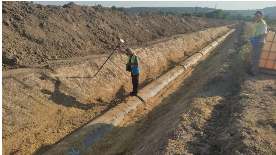
Рис. 2.3.4. Розмітка лінії зворотної засипки глини
