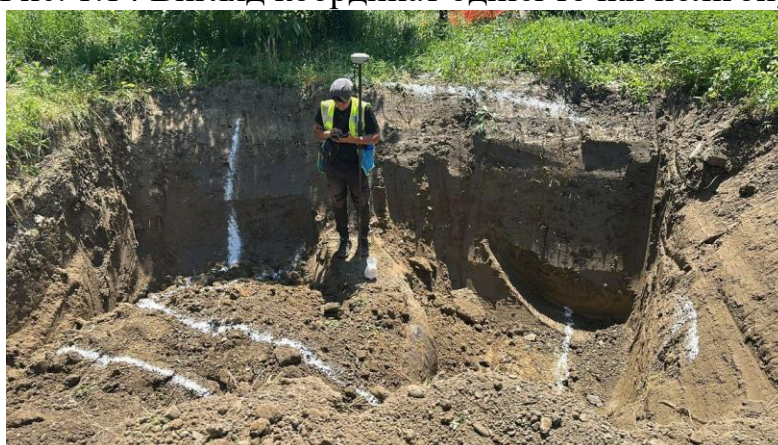
Рис. 1.15 Розмічування камери та вирахування рівня ескавації
