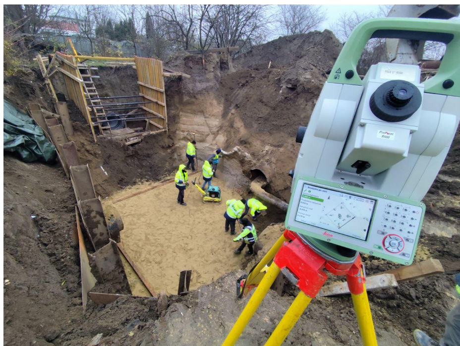
Рис. Встановлений тахеометр на будмайданчику.
