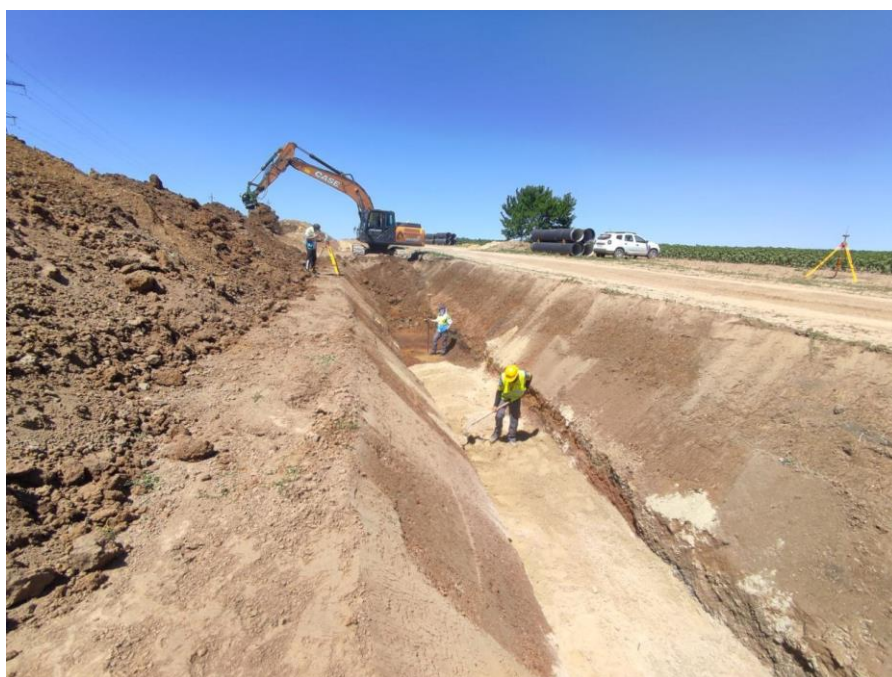
Рис. 1.1.5 Вигляд викопаної траншеї та засипки подушки із піску під трубу
