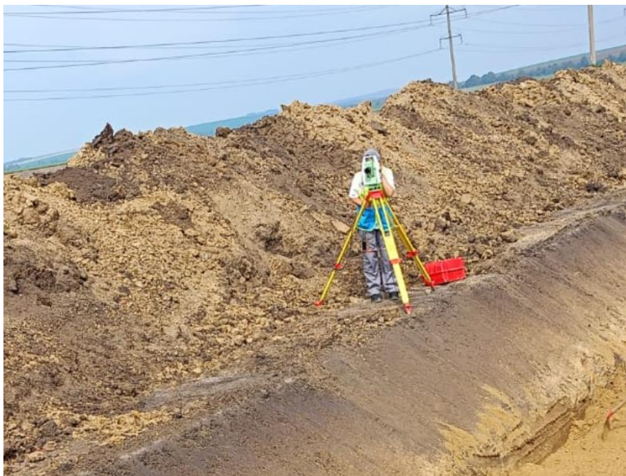
Рис. 2.3.7 Вигляд проведення тахеометричної зйомки траншеї
