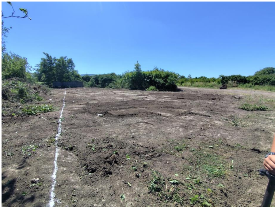
Рис. 1.3.3 Розмітка лінії водогону та межі робочої зони
