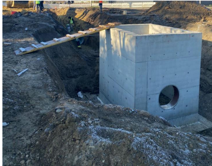
Рис. 2.3.14 Вигляд готової камери
