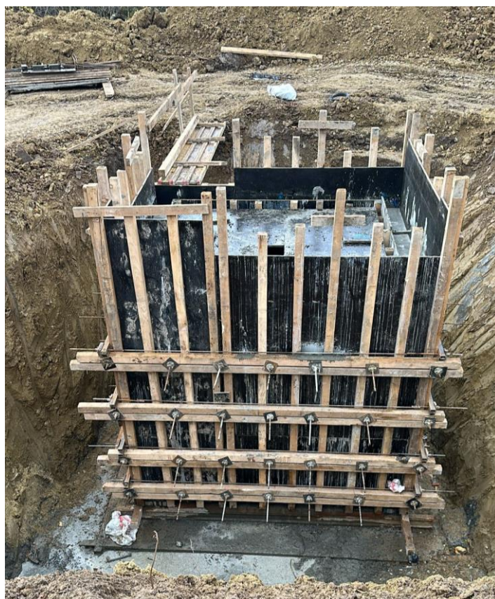
Рис. 2.3.13 Вигляд опалубки стін камери
