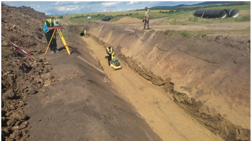
Рис. 2.1.10 Трамбування 10 см шару піску
