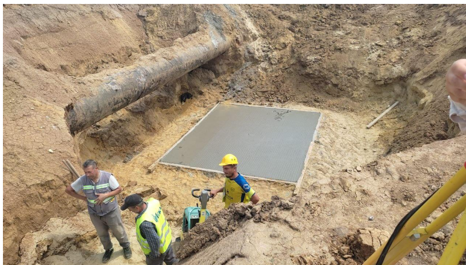
Рис. 1.1.10 Вигляд бетонної підготовки перед фундаментом (підбетонка)
