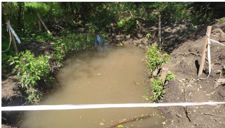
Рис. 2.1.5 Вигляд впливу підземних вод та невеликого струмка
