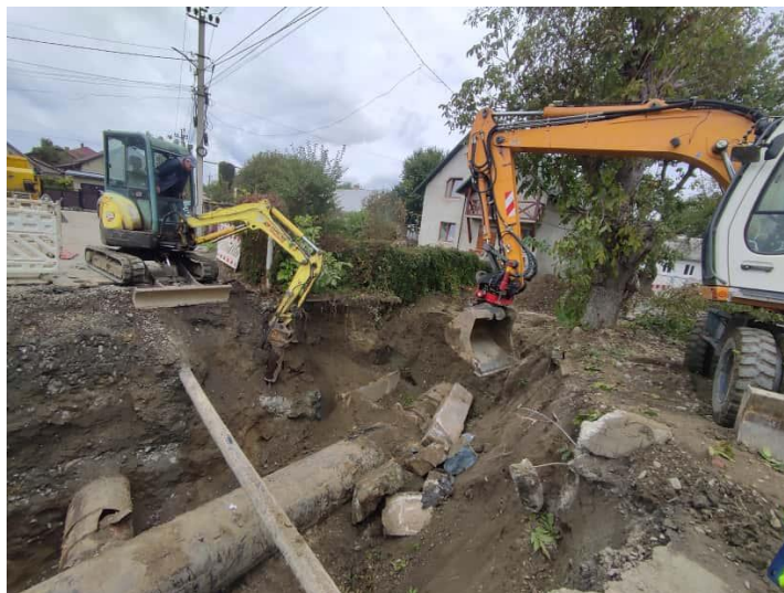
Рис. 3.3.4 Вигляд обмежених умов роботи та скупчення техніки із присутньою постійною вібрацією
