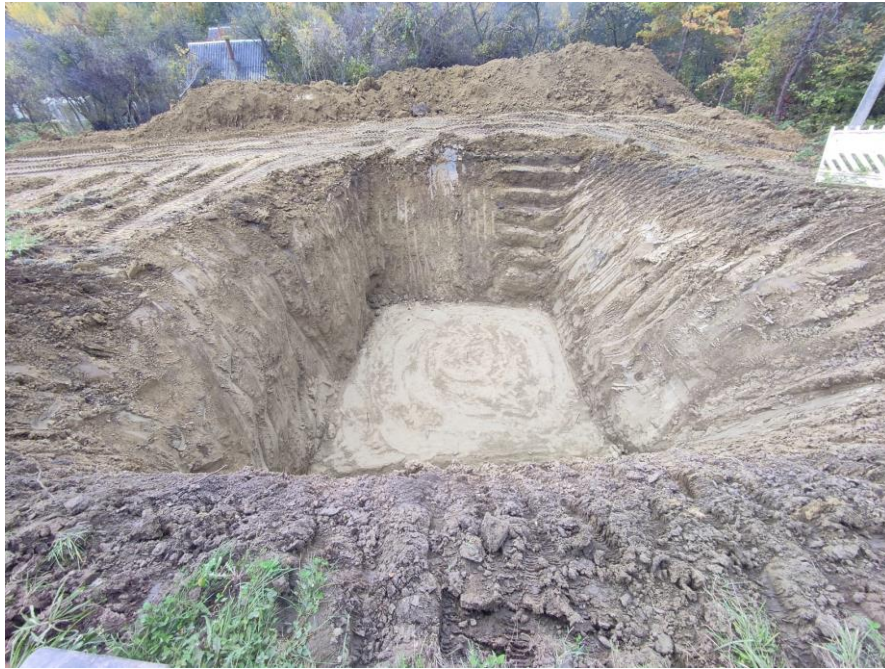
Рис. 2.3.10 Вигляд засипки та трамбування піску на дні камери
