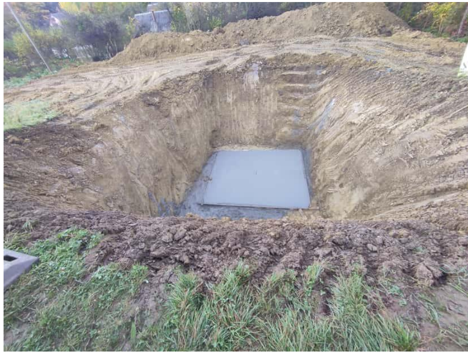
Рис. 2.3.11 Вигляд бетонної подушки
