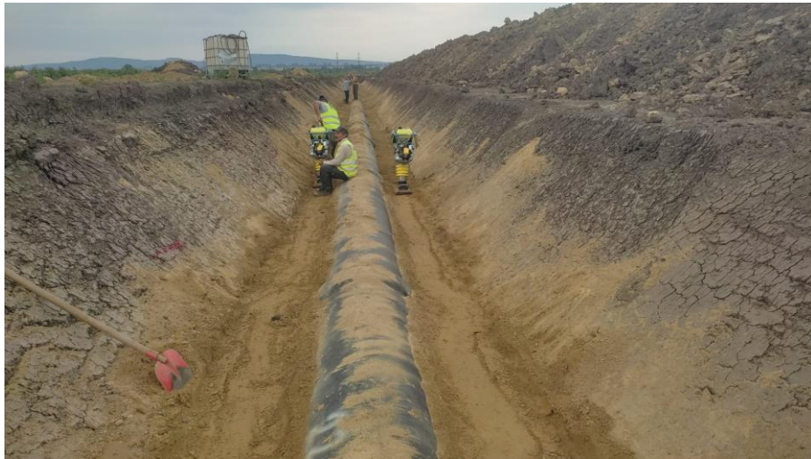
Рис. 2.3.2 Вигляд ручних трамбівок
