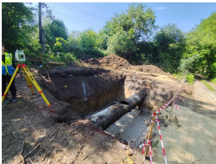
Рис. 1.13 Встановлення тахеометра та прив'язка до полігону
