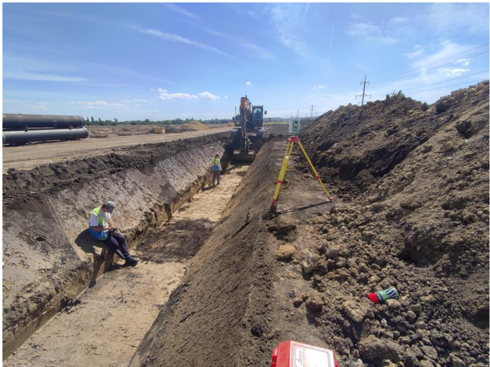
Рис. 2.1.8 Копання траншеї із геодезичним супроводом.
