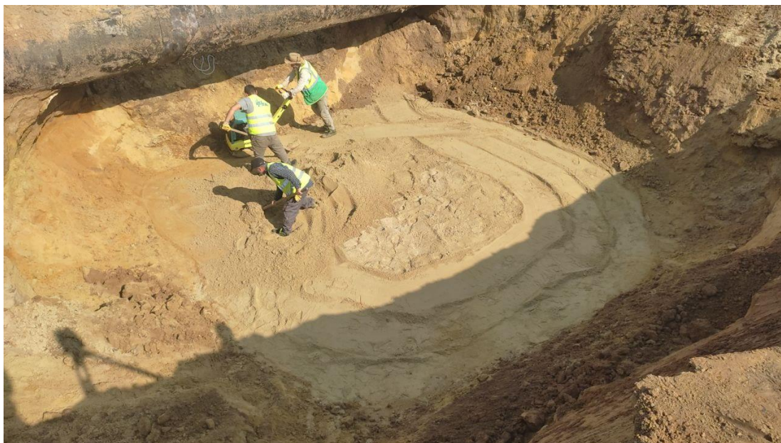
Рис. 1.1.9 Вигляд підготовки піщаної подушки камери
