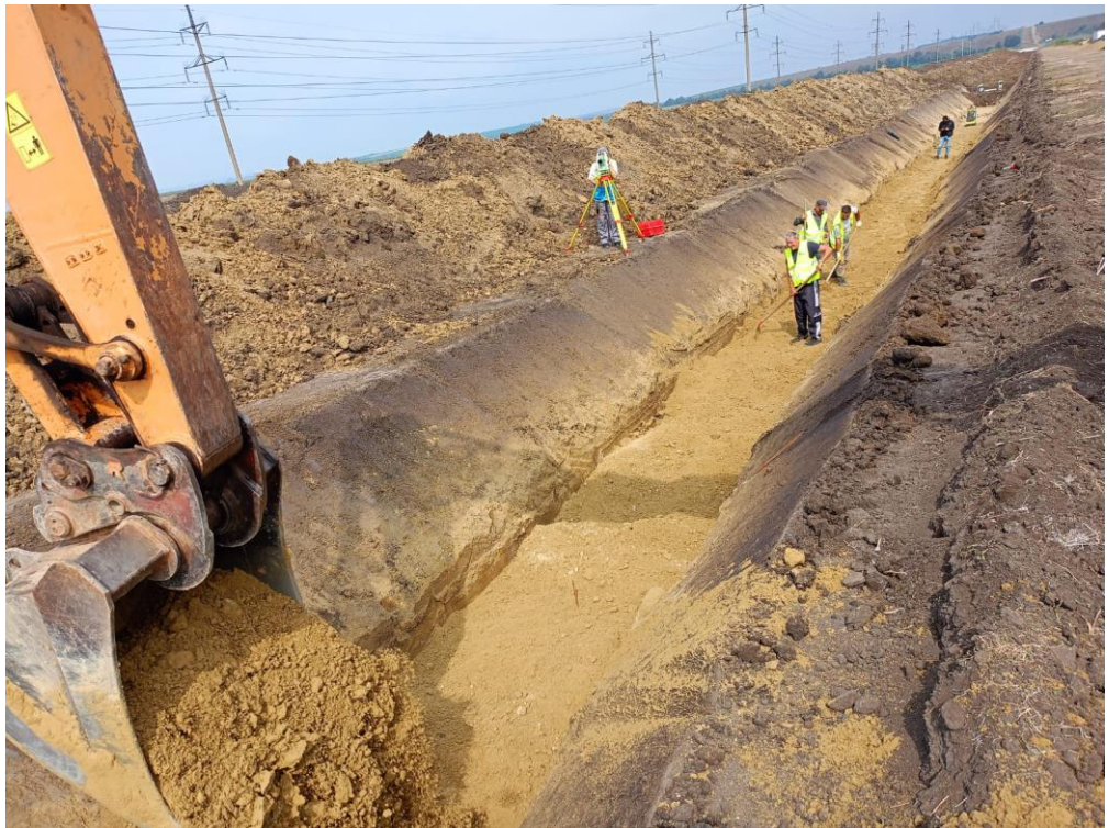
Рис. 2.1.9 Вигляд засипки 10 см шару піску
