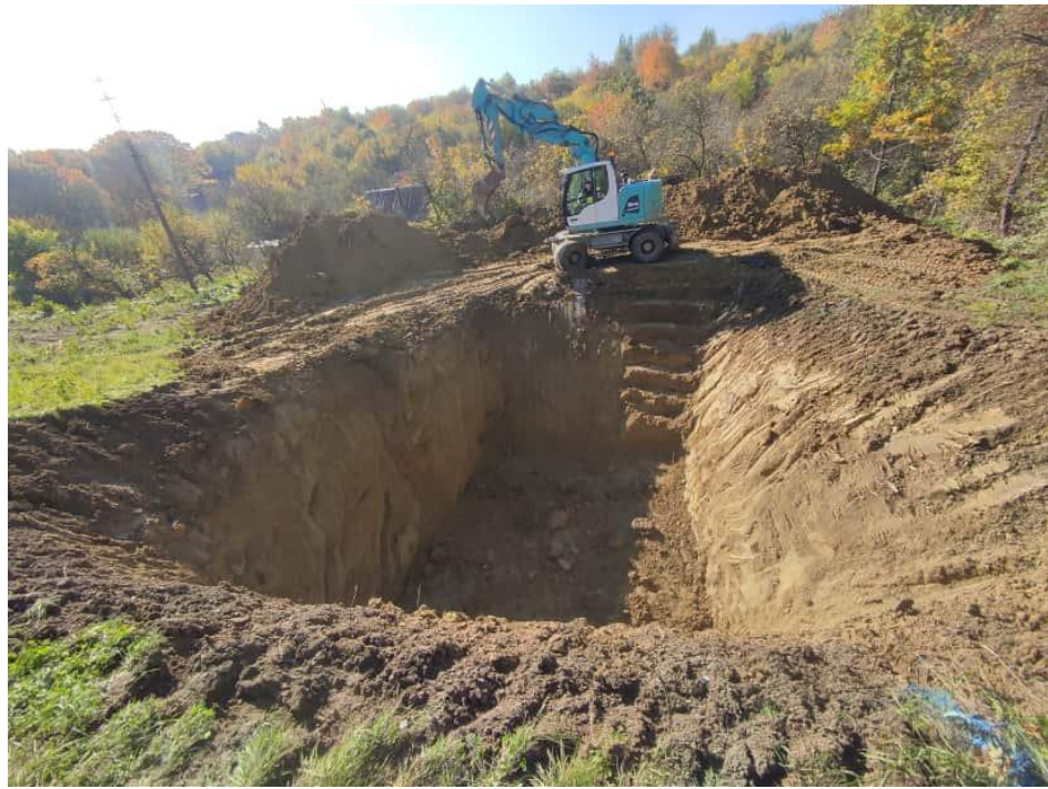
Рис. 2.3.9 Вигляд ескавації камери ( глибина 4.5 – 5 м.)
