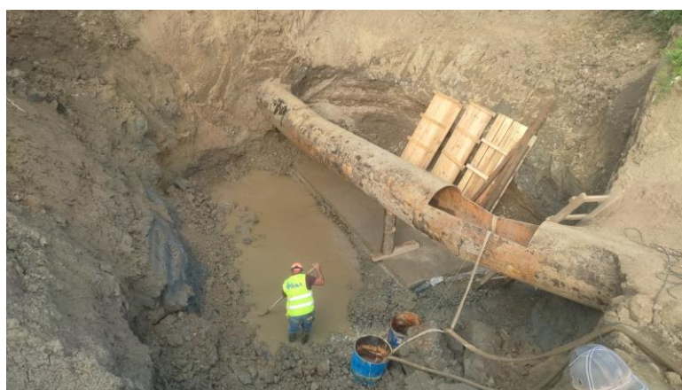
Рис. 2.1.6 Вигляд швидко підступаючої води із-за підземних вод, та їх постійне викачування
