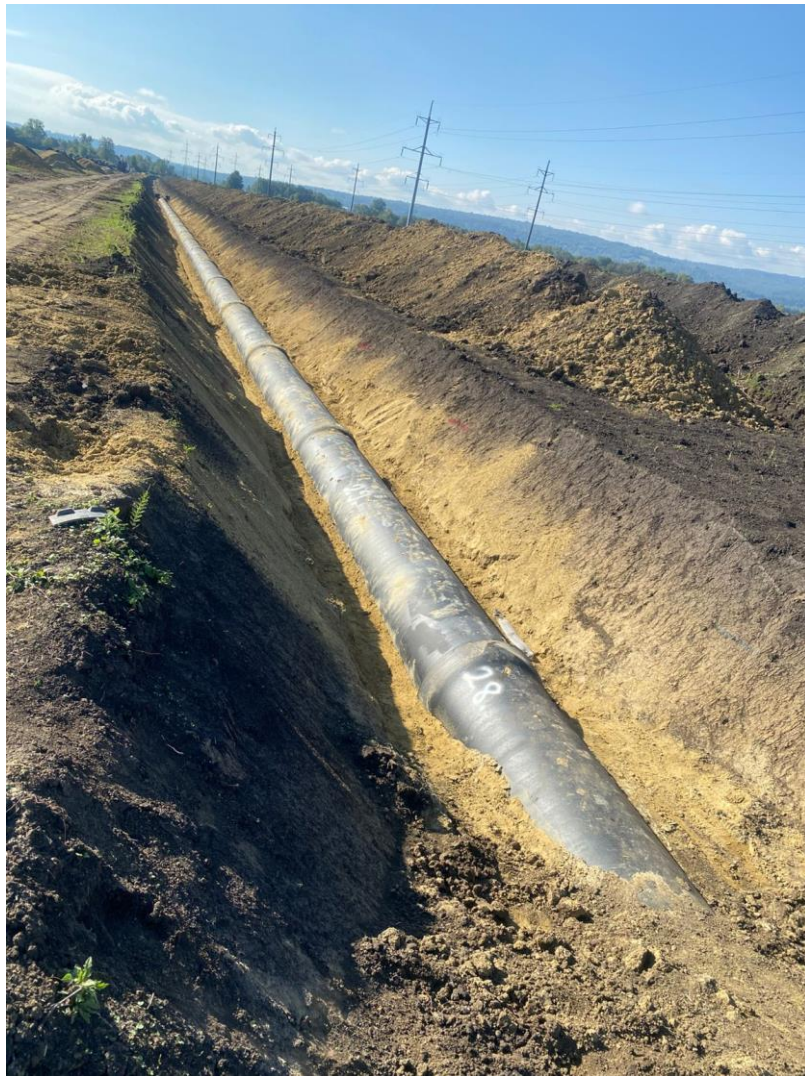
Рис. 2.3.3 Фінальний вигляд засипки 40 см шару піску
