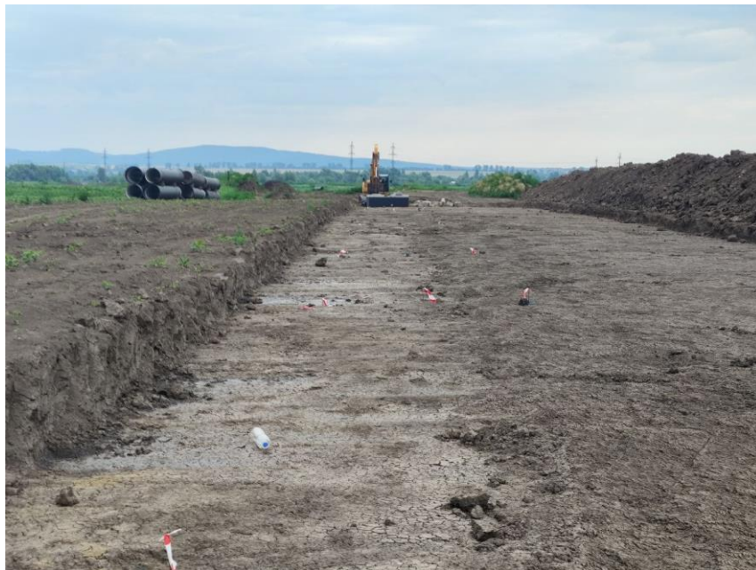
Рис. 1.2.2 Розмічування проектної лінії труби та верху траншеї
