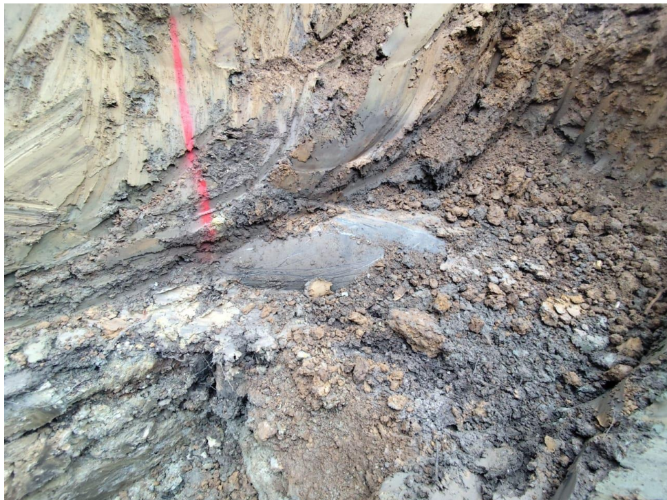
Рис. 3.2.7 Приклад фотофіксації похованої труби якої не було на топографічній зйомці
