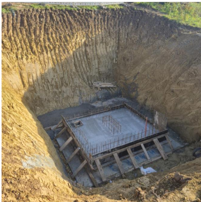
Рис. 2.3.12 Вигляд Фундаменту камери
