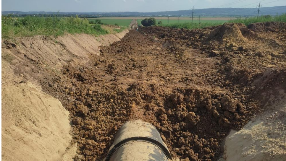
Рис. 2.3.6. Вигляд 30 см глини поверх труби
