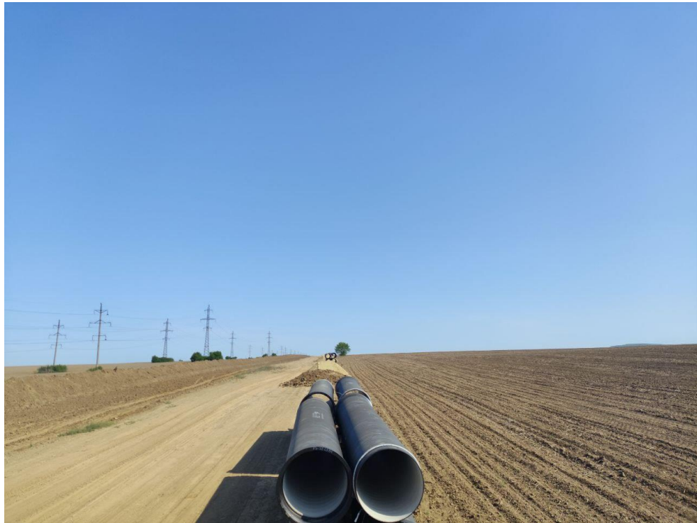
Рис. 1.1.3 Вигляд розвантажених труб DN800
