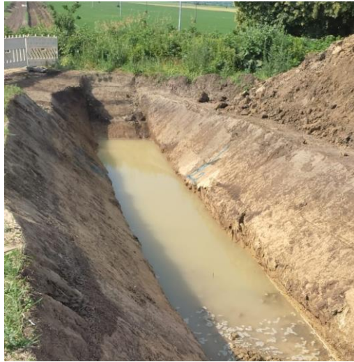
Рис. 2.1.7 Вплив пошкодженої сусідньої гілки водогону
