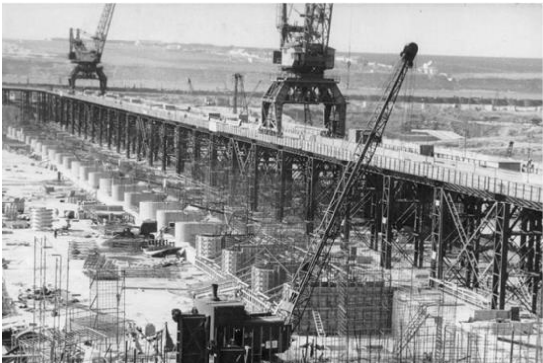
Будівництво Каховської ГЕС, 20 серпня 1954 року
