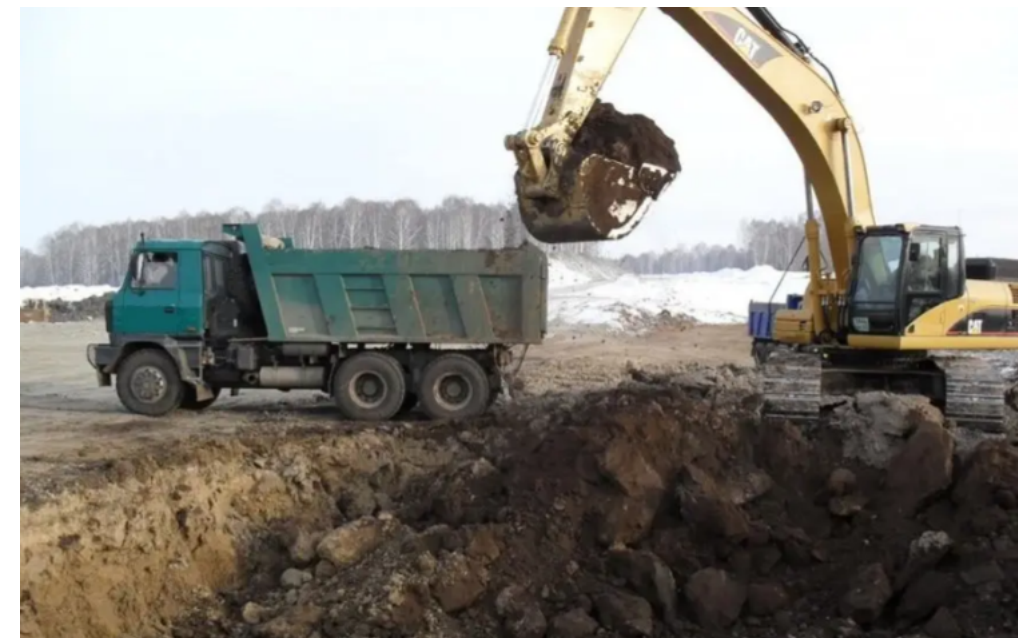
Рисунок 3 – Розробка ґрунту котловану у транспортний засіб
