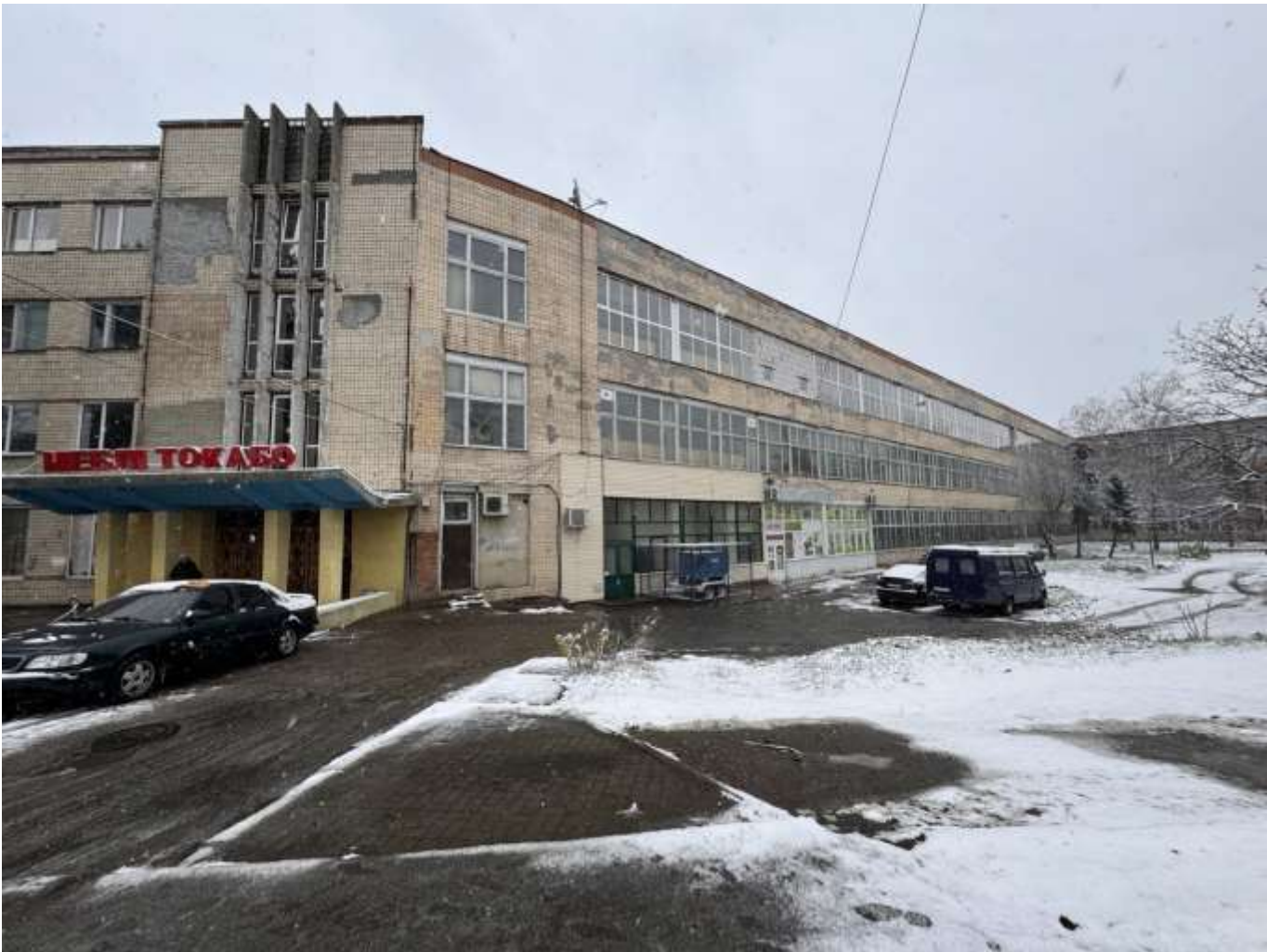
Рис.1. Існуючий фасад будівлі по осям 10-28
