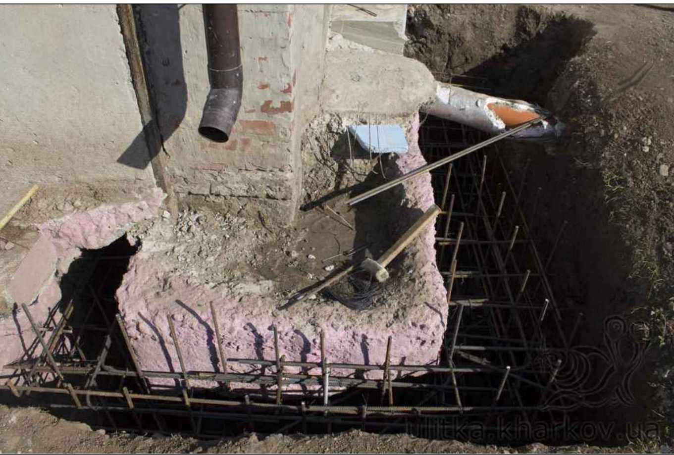
Посилення методом армуванням стрічкових фундаментів
