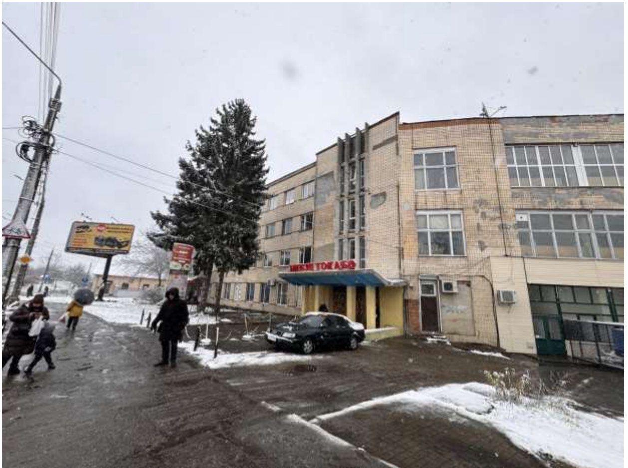
Рис.2. Існуючий фасад будівлі по осям 1-9
