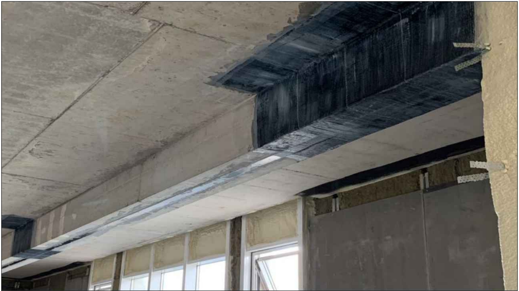
Посилення балки композитним матеріалом
