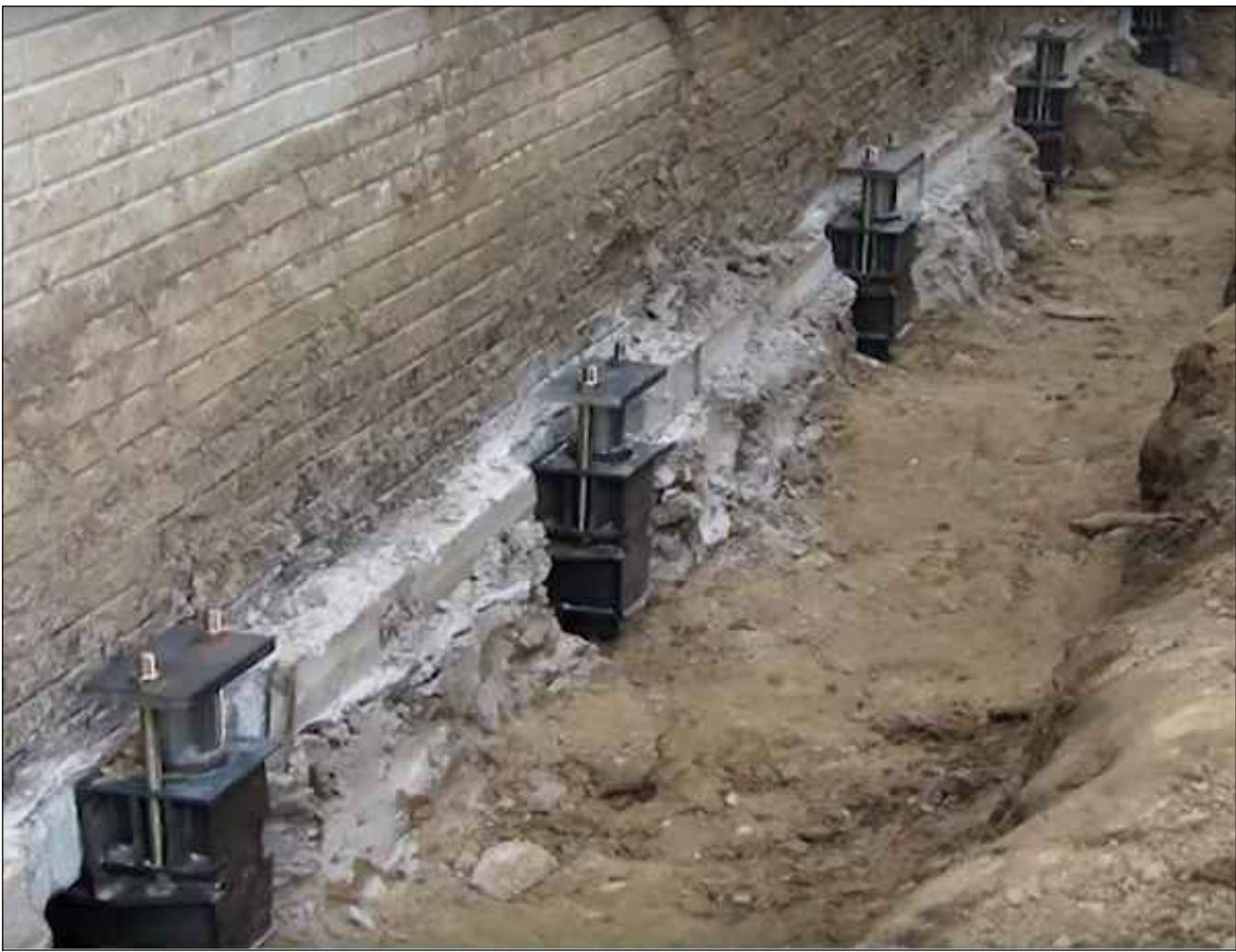
Посилення фундаменту методом додаткових пальових опор
