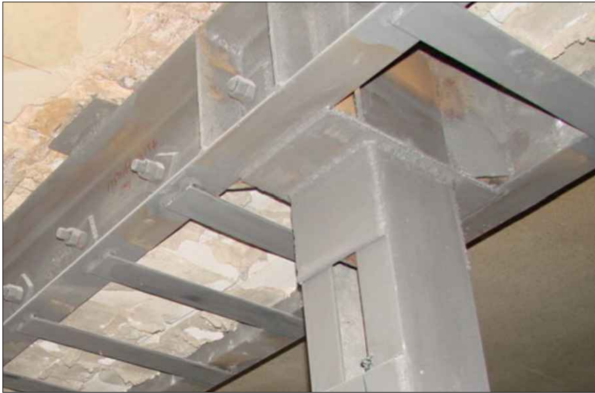
Посилення жорсткою опорою з додатковими затяжками
