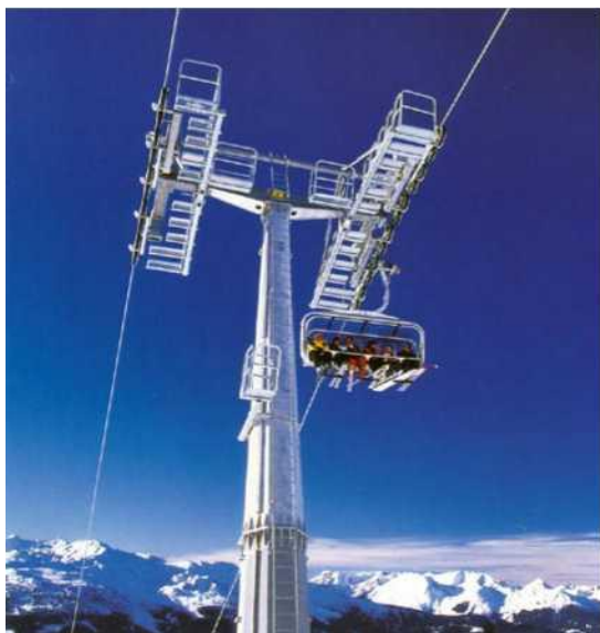
а) загальний вид;
