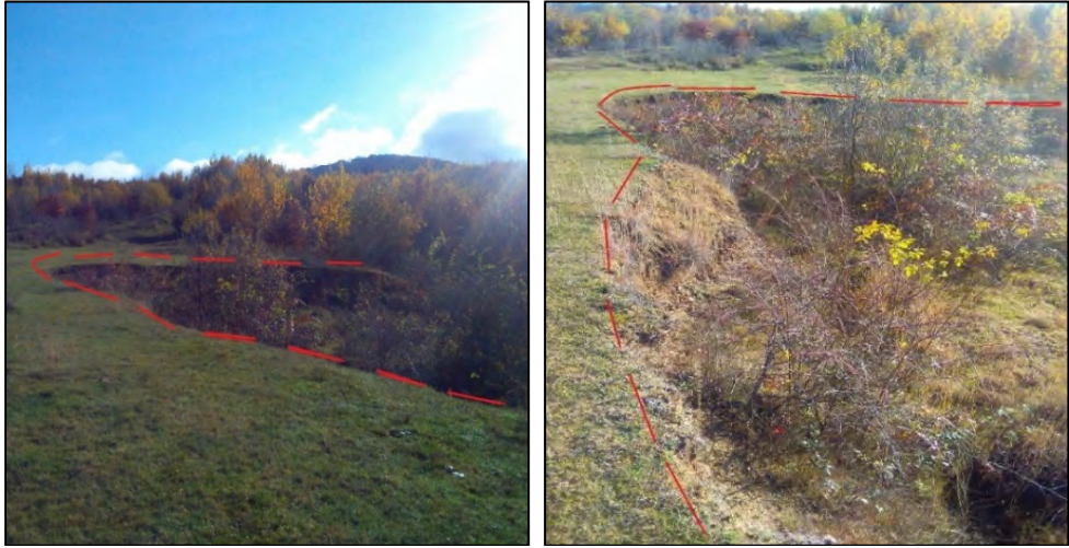
Fig. 3. Landslide in Chelintă
