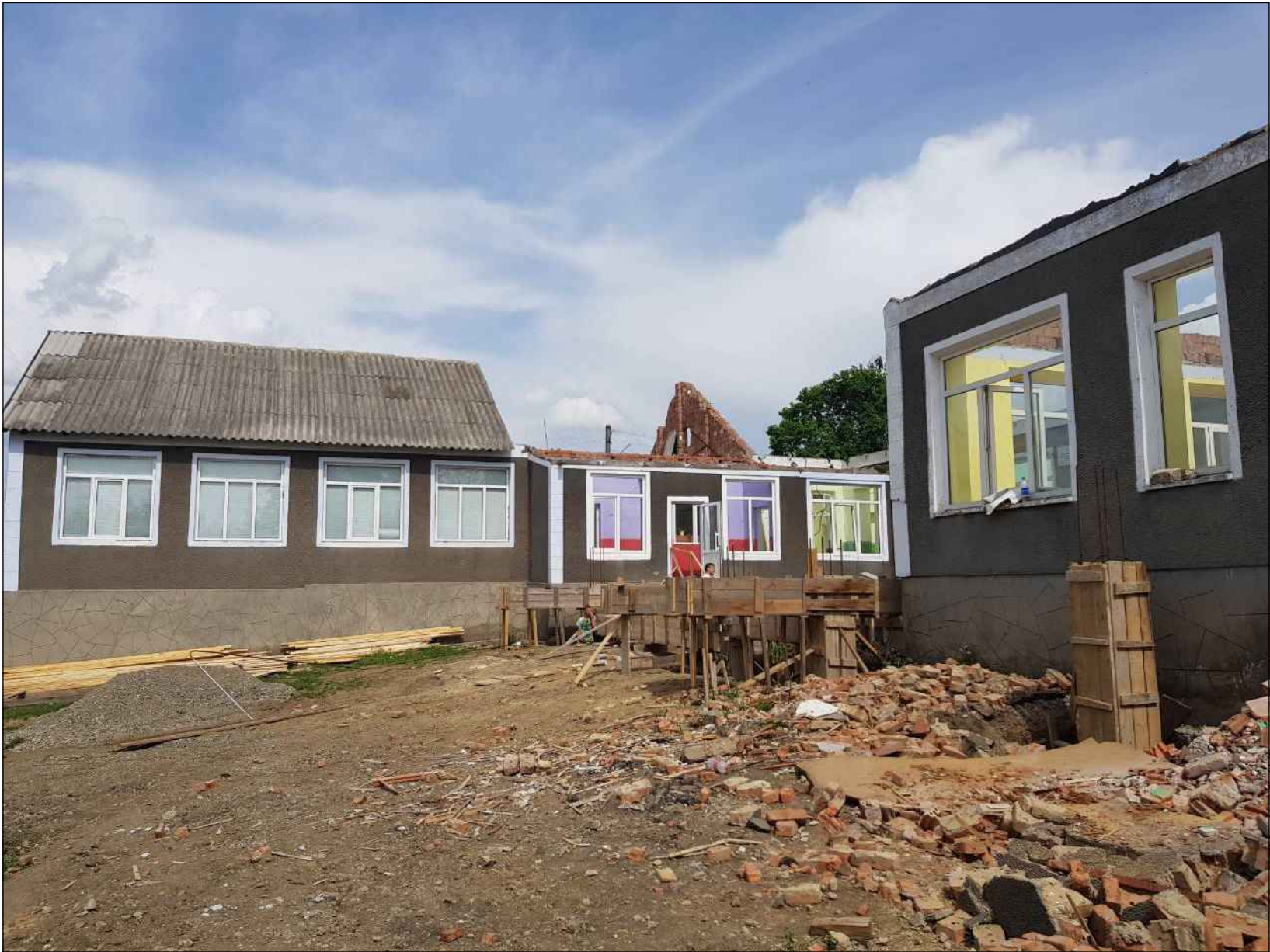
Рис.2 Існуючий фасад садочка
