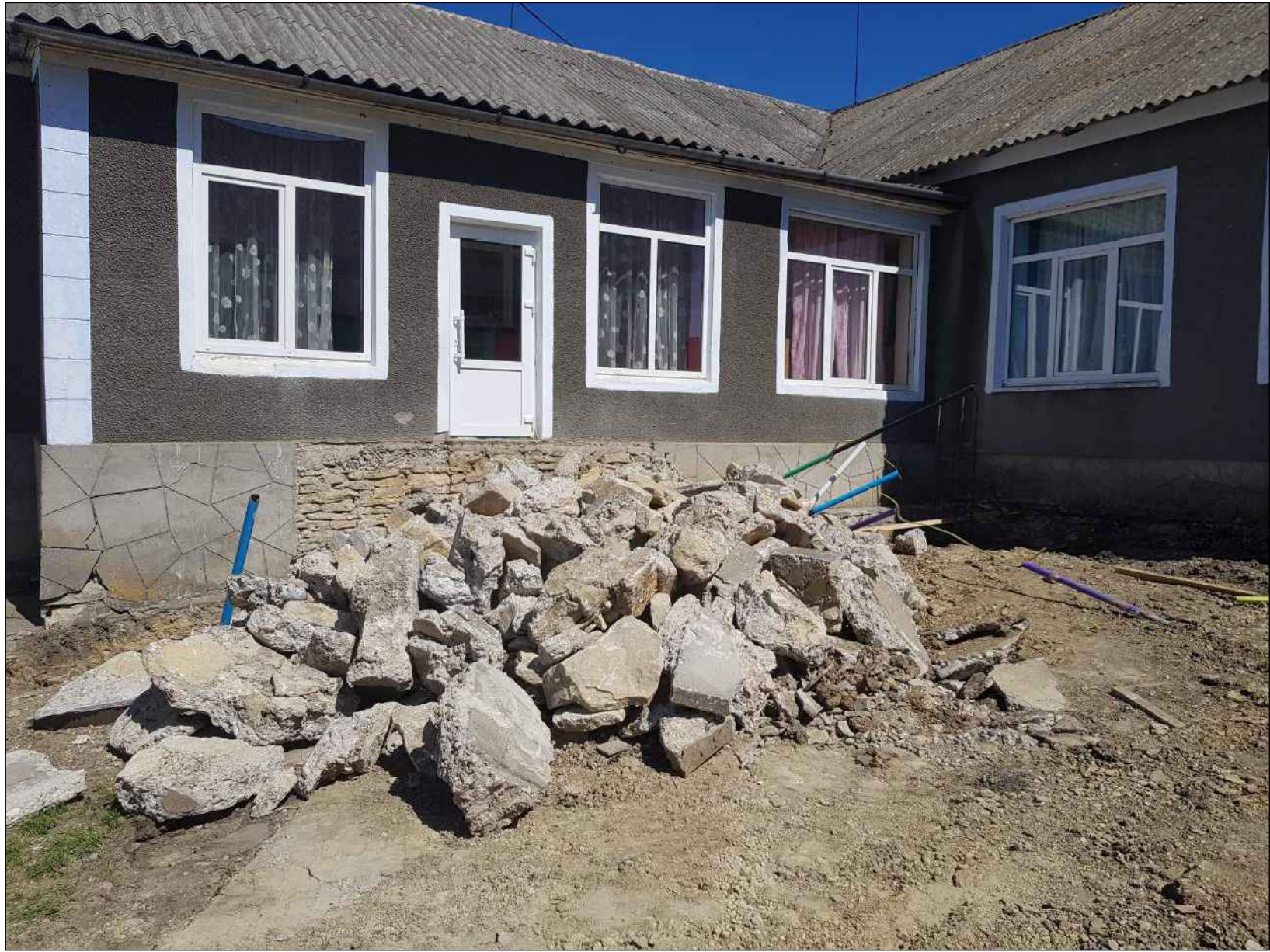
Рис.1 Існуючий фасад садочка
