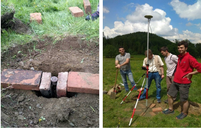
Рисунок 4.21. Закладення геодезичного пункту згущення викладачами та студентами кафедри геодезії, картографії та управління територіями географічного факультету Чернівецького національного університету імені Юрія Федьковича.
