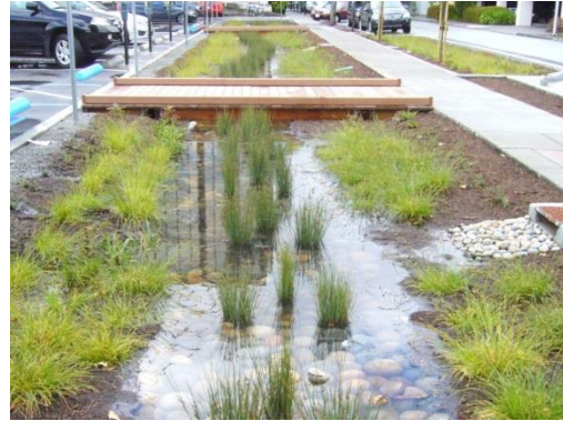
Рис. 2. Приклад реалізації дощового саду (джерело: відкриті джерела).
