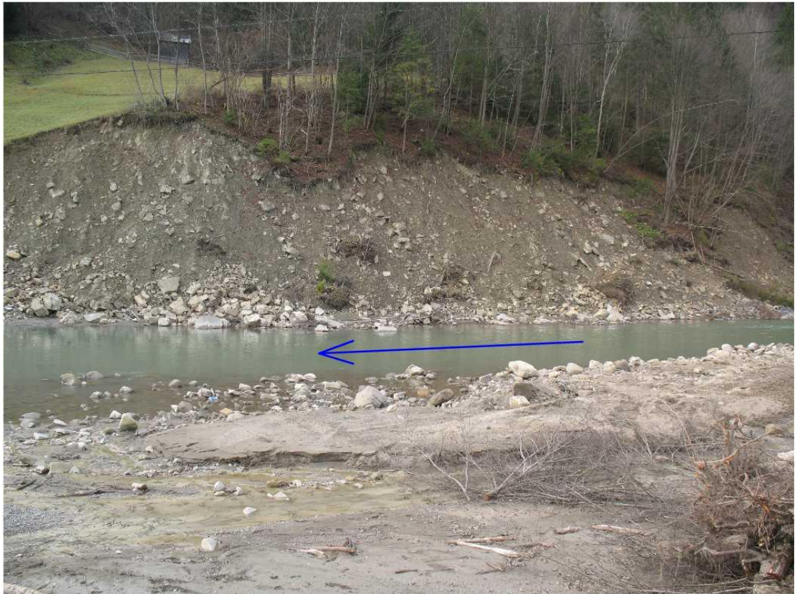
Рис. 3.3. Зміщення русла р. Ільця біля с. Кривопілля до правого берега внаслідок розмиву, після паводку.
