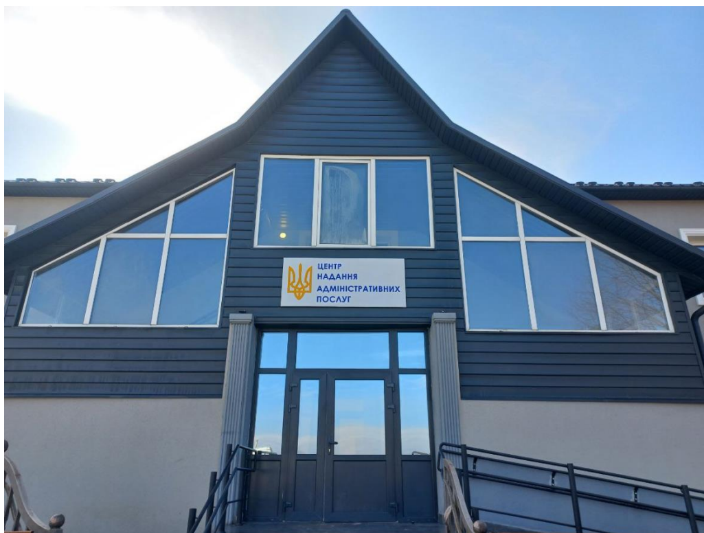
Рис. 3. Оновлений фасад ЦНАПу
