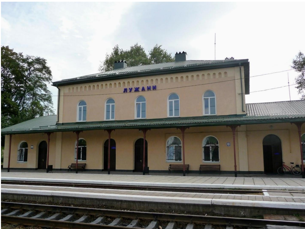
Рис.3.3. Залізнична станція с. Лужани
